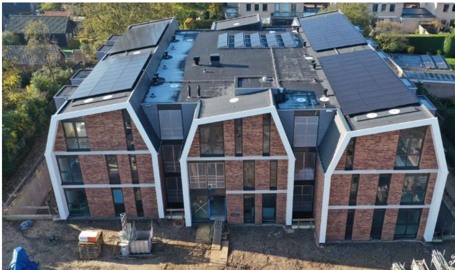
Het Mooi Leven Huis in aanbouw (november 2019)
